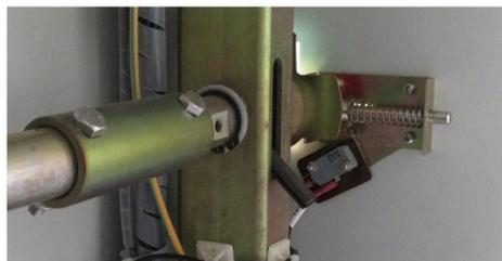
隔离开关与断路器闭锁 机械/电气
