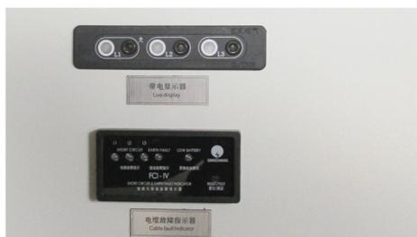
温湿度控制 / 带电显示 / 电缆故障指示
